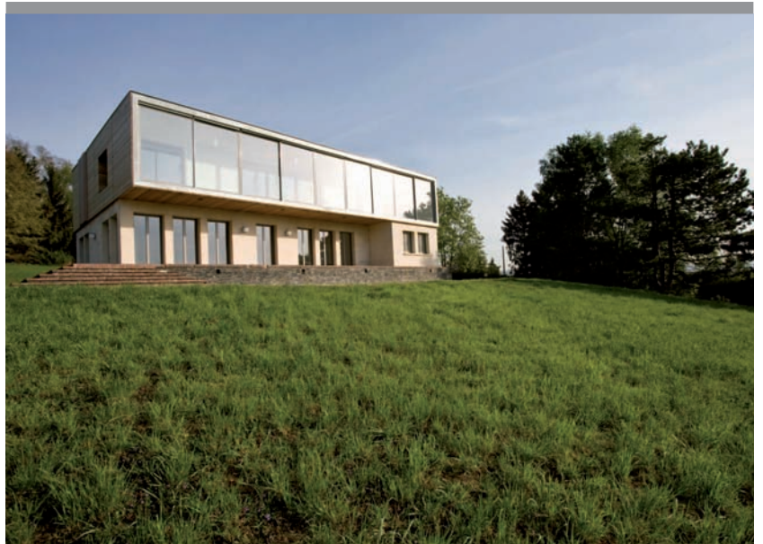
VUE SUD GÉNÉRALE, AVEC SAS THERMIQUE VITRÉ.
