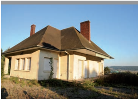
MAISON DANS SON ÉTAT EXISTANT.
