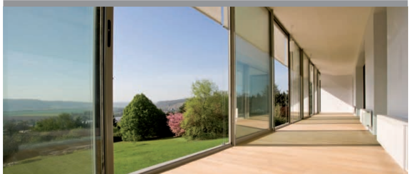
VUE DEPUIS LE SAS THERMIQUE, LIEU DE VIE ET D'ÉCHANGE FAMILIAL.
