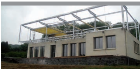
INSTALLATION DE L'OSSATURE PRIMAIRE EN MÉTAL.
